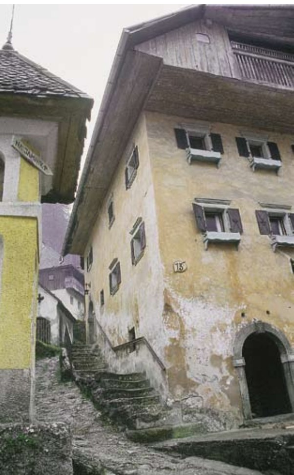
Pibrovčeva hiša v Kropi pred obnovo
